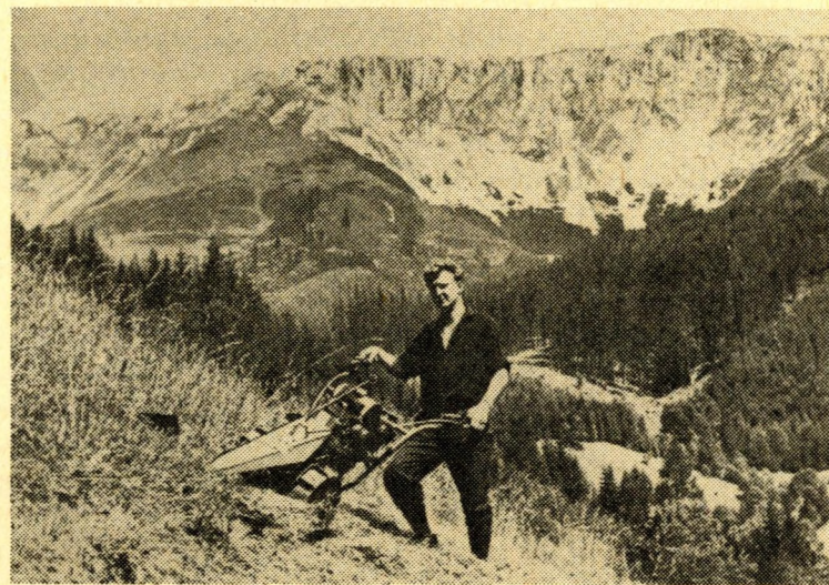
Obr.3. Ruční kosačka pro velmi sklonité břehy toků.
