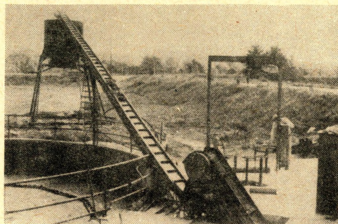
Obr.5. Česle, dopravník a zásobník u zahušťovací nádrže kalu.
