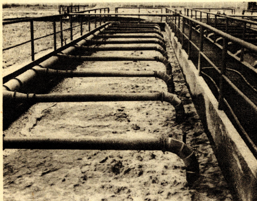
Čistírna v Dubnici n.V. - aktivace systém INKA (Foto P.Michálek, VÚV-Praha)
