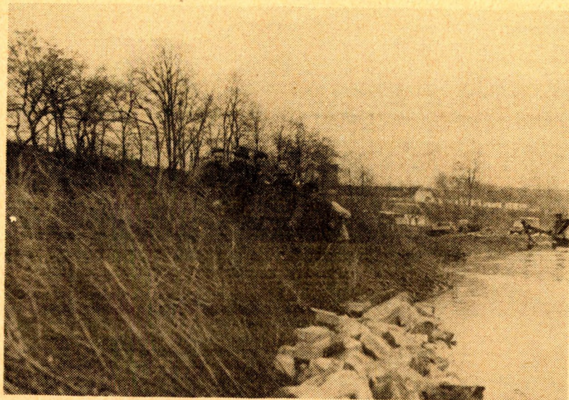
Obr.2. Ostranění ostrovů na řece Dyji v úseku Oblekovice - Starý Šaldorf. Provádění vrbového pokrytu.
