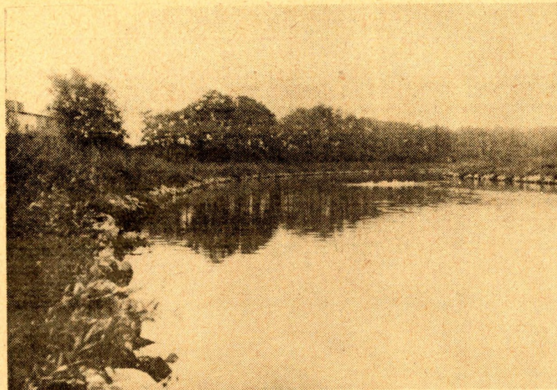
Obr.3. Odstranění ostrovů na řece Dyji v úseku Oblekovice - Starý Šaldorf. Stav po- rostů v září 1965.
