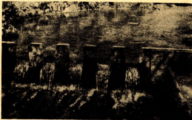
Obr.1. Dřevěný měrný přepad - Velký Hubenov, povodí Obrtky
