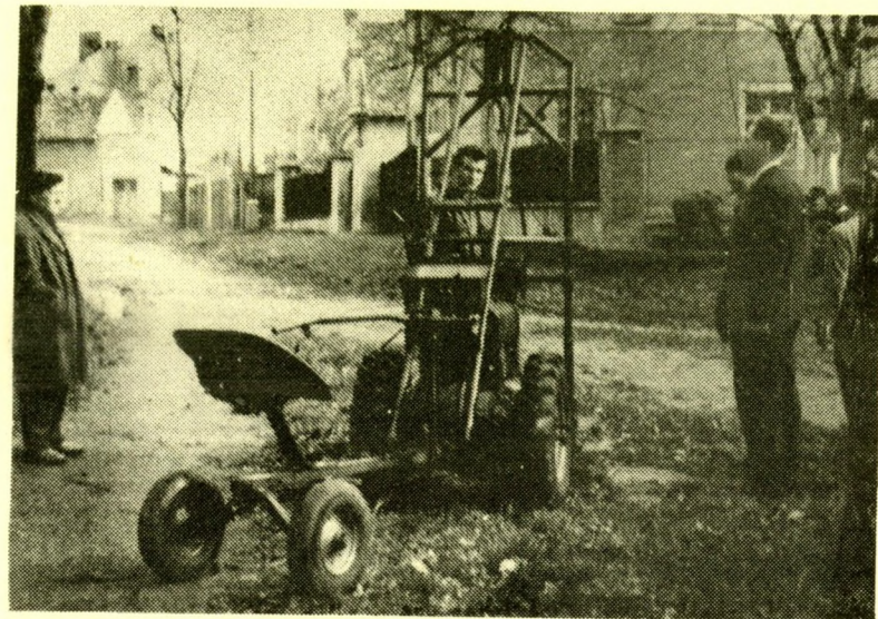
Soupravana čištění neprůlezných stok podle ZN inž.dr. Halámka z KVRIS Bratislava. V roce 1964 zajišťuje vý- robu dílna OVHS Uh. Hradiště i s dodávkou motorobotu.
