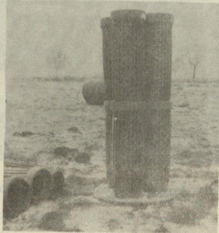
Bateriový trojfiltr 2x kam. \varnothing 300 mm hrdlová 1x kam. \varnothing 250 mm hrdlová na spouštěči \varnothing 800 mm
