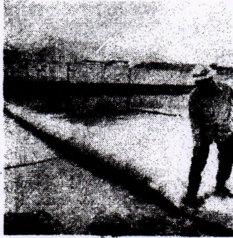
Obr.2. "ypuštěný neoprenový jez. Při vysoké vodě vyprazdňuje se automaticky ve 12 min.
