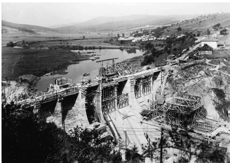
Obr. 7. Stavba hráze Kníničské přehrady, v pozadí zatopená obec Kníničky, 1939 (archiv MČ Brno-Kníničky/Z. Čížmář)
