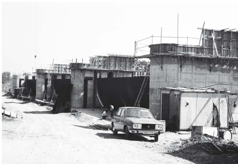
Obr. 10. Stavba hráze dolní novomlýnské nádrže, 1987 (Povodí Moravy, s. p.)
