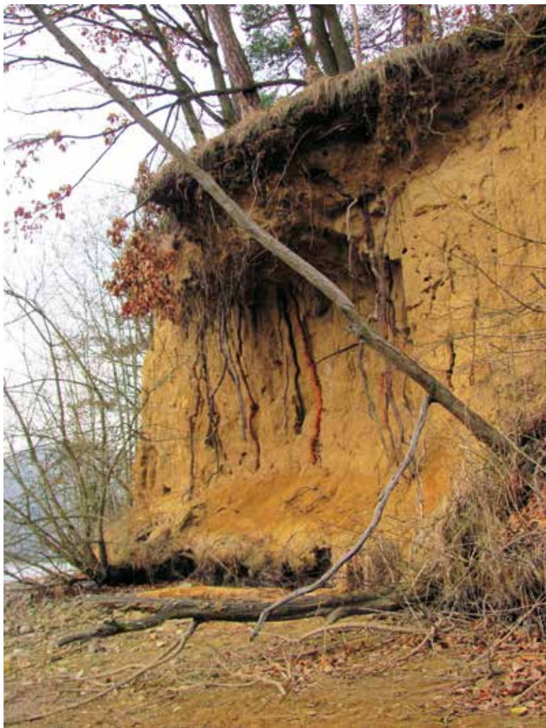
Obr. 2. Vodní dílo Brno, oblast Osada – abrazní srub Fig. 2. Brno dam reservoir, Osada area – abrasion cover
