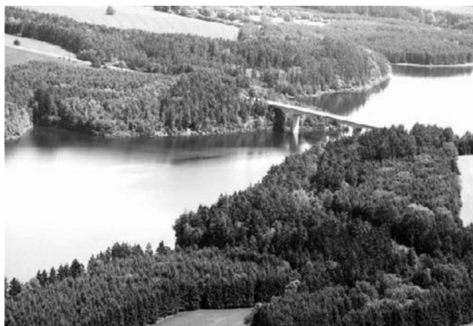
Obr. 2. Dálniční most přes vodní nádrž Švihov (ilustrační foto P. Prouza, www.dalnice.com)
