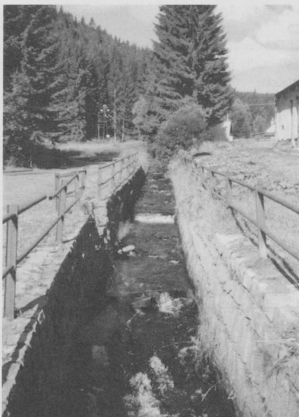
Kotelník potok pod úpravnou vody Karlov (foto autor)
