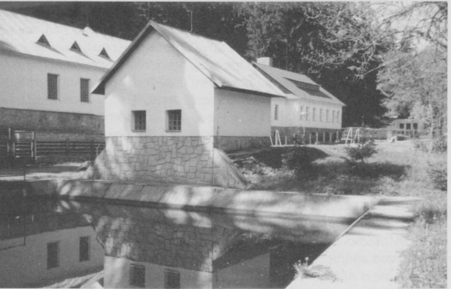
Úpravna vody Karlov – sedimentační nádrž odpadních vod z praní filtrů (foto autor)
